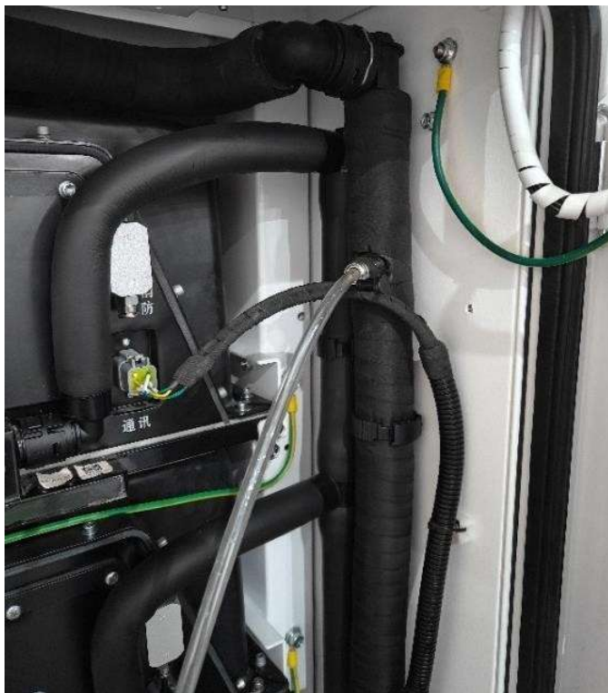
Fig. 9-22 Haga circular el líquido refrigerante, devolviendo las burbujas libres al depósito
