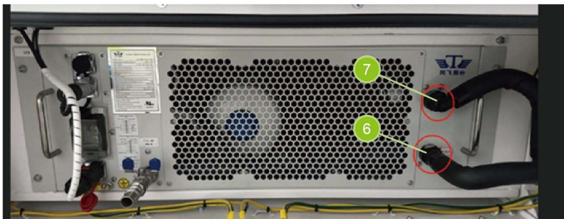
Fig. 9-13 Remova os tubos de entrada e saída do líquido de resfriamento
