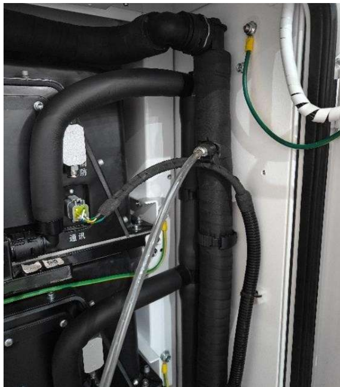
Fig. 9-22 Faça circular o líquido de arrefecimento, levando as bolhas livres de volta para o recipiente
