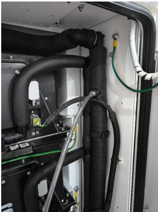
Figura Anexo 6- 25 Observe el proceso de inyección de líquido
