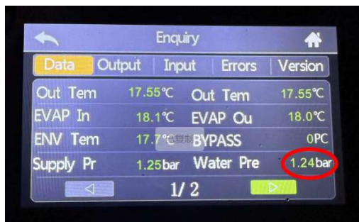
Figura Anexo 6-21Ecrã de exibição da pressão da água de retorno
