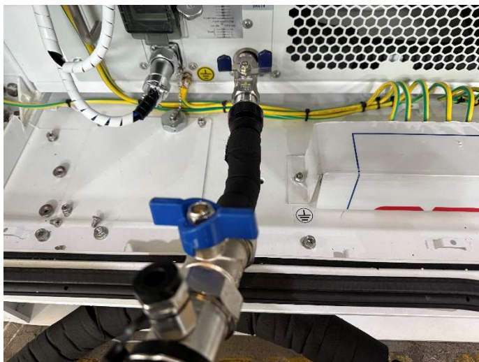
Figura Anexo 6-24 Conecte ambas as extremidades da bomba de enchimento
