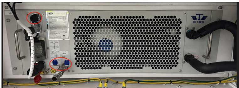
Figura Anexo 6-17 Fiação do visor da unidade de refrigeração líquida e posição da válvula de drenagem
