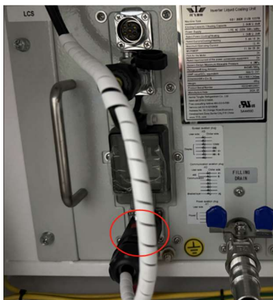
Figura Anexo 6-19 Posição da ficha de alimentação na unidade de refrigeração líquida
