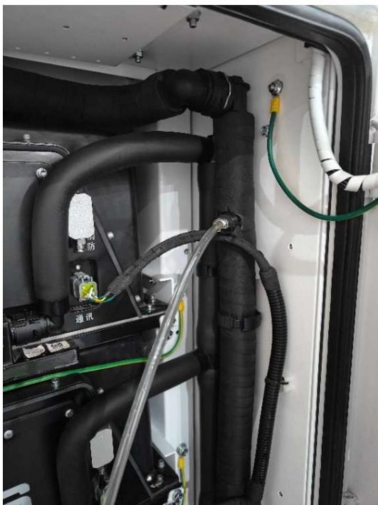
Figura Anexo 6-25 Observe o processo de injeção de líquido
