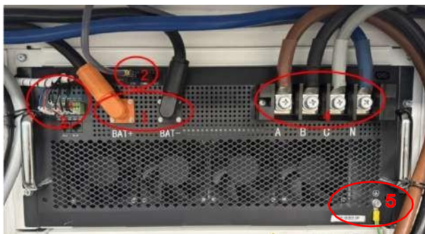
Figura Anexo 6- 36 Retire las líneas de conexión externas del PCS
