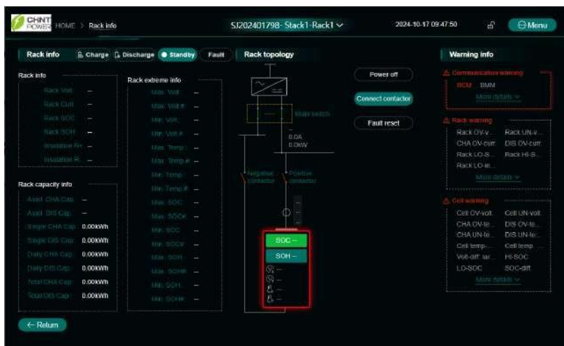
Figura 6-10 Parámetros del grupo de baterías (referencia)
