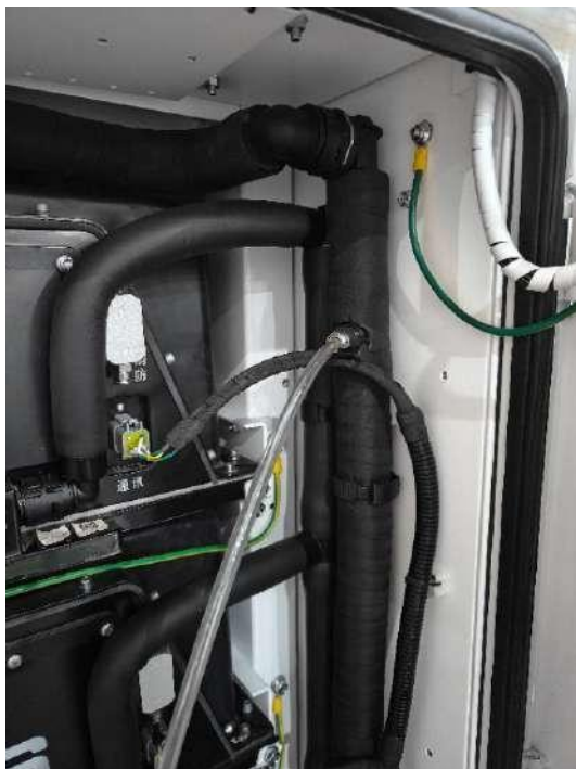
Figura Anexo 6- 24 Observe el proceso de inyección de líquido
