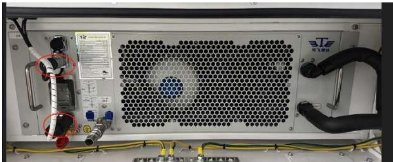
Figura Anexo 6-12 Interfaces de comunicación y alimentación eléctrica
