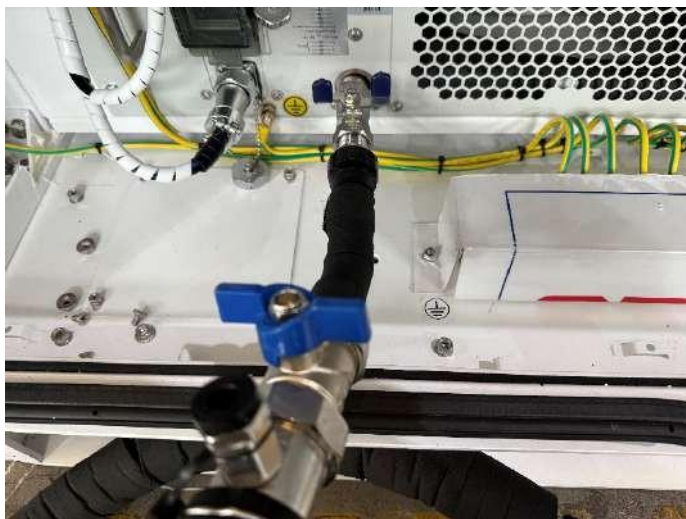
Figura Anexo 6- 23 Conecte ambos extremos de la bomba de llenado
