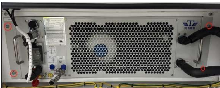
Figura Anexo 6-14 Posición de los tornillos de fijación de la unidad de refrigeración líquida
