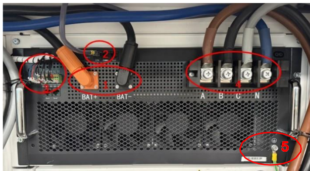
Figura Anexo 6- 36 Remova as linhas de conexão externas do PCS
