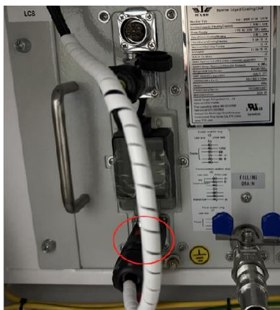
Figura Anexo 6-18 Posição do plugue da fonte de alimentação na unidade de resfriamento líquido
