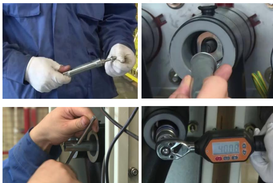
Figura 3-29 Instalar la tuerca y la arandela
