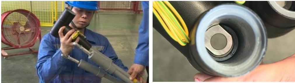
Figura 3-27 Empuje el cable en el conector en T
