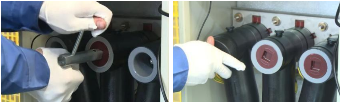
Figura 3-32 Instalar la tapa final
