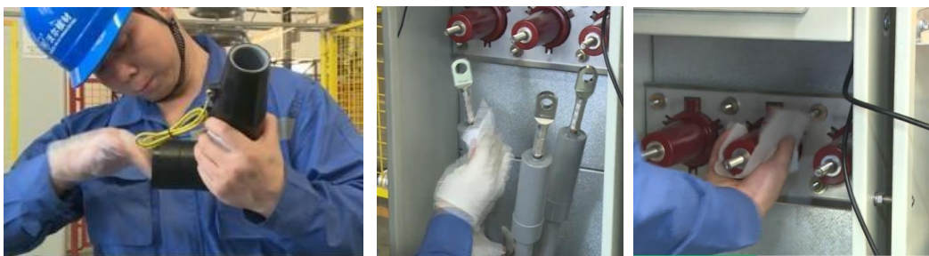
Figura 3-26 Limpie el conector en T, el adaptador de cable y el casquillo, y aplique grasa.
