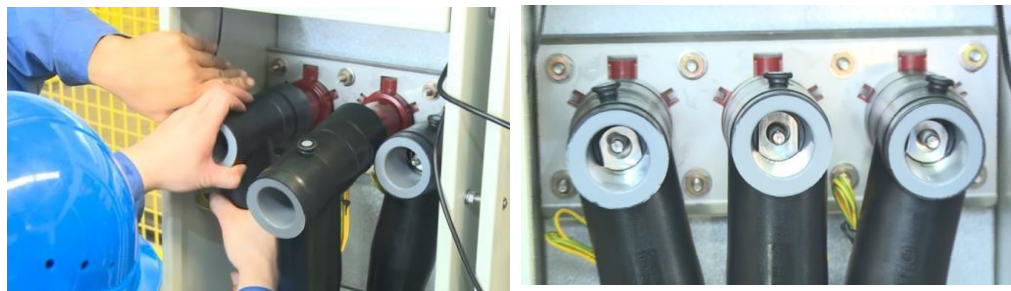
Figura 3-28 Empuje el conector en T y el adaptador de cable en el casquillo
