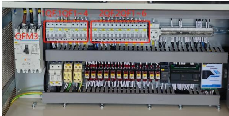
Figura 4-3 Posición de QFM3, 1QF, 1QF1~4, 2QF, 2QF1~6
