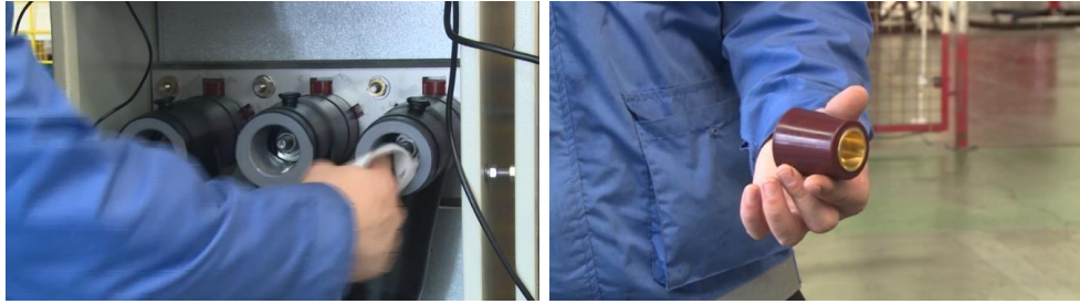
Figura 3-30 Limpie el conector en T y el tapón aislante y aplique grasa.
