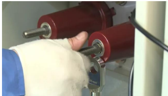
Figura 3-25 Apriete el tornillo de doble cabeza M16/M12 en el casquillo
