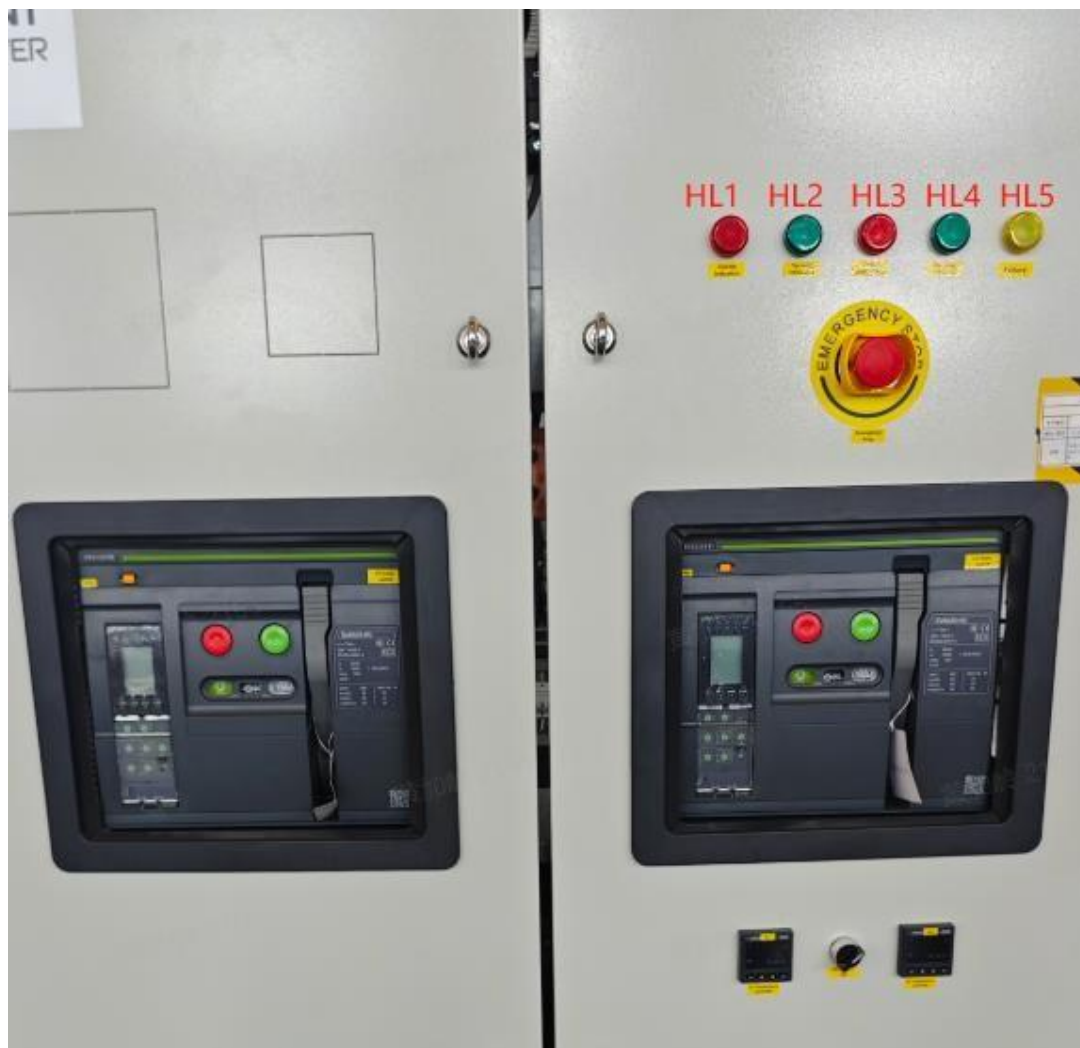
Figura 4-5 Indicadores do gabinete de baixa tensão
