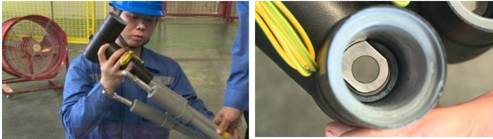
Figura 3-27 Empurre o cabo para dentro do conector em T
