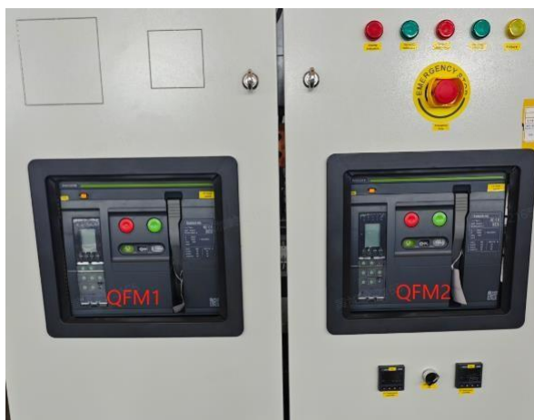
Figura 4-4 Posição do QFM1 e QFM2
