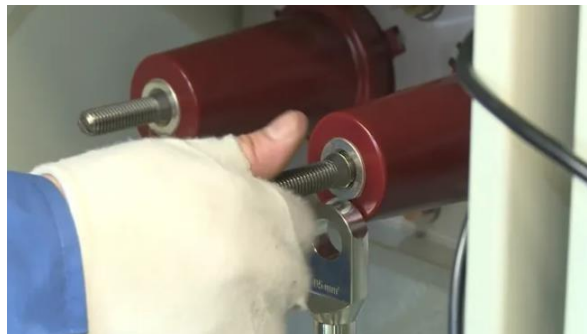
Figura 3-25 Aperte o parafuso de duas cabeças M16/M12 na bucha
