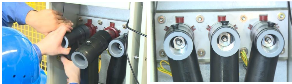
Figura 3-28 Empurre o conector em T e o adaptador de cabo para dentro da bucha
