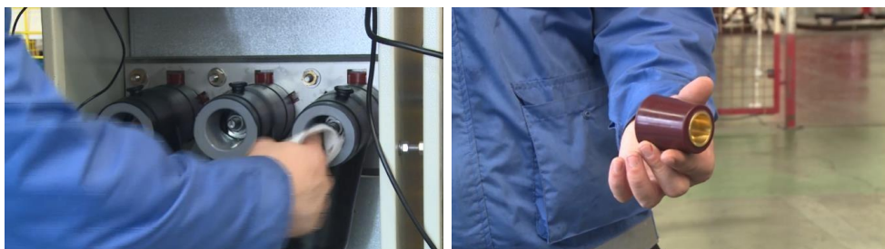
Figura 3-30 Limpe o conector em T, o plugue isolado e aplique graxa
