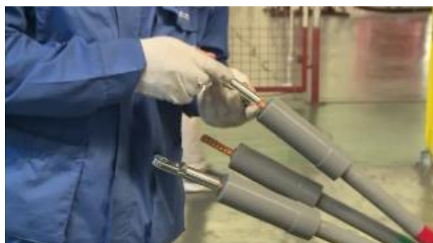
Figura 3-22 Insira os terminais em cada condutor de fase
