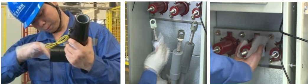
Figura 3-26 Limpe o conector em T, o adaptador de cabo, a bucha e aplique graxa
