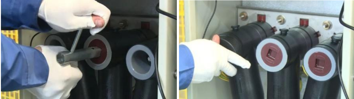
Figura 3-22 Instale la tuerca y la arandela.
