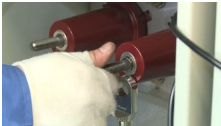
Figura 3-18 Inserte los terminales en cada conductor de fase.
