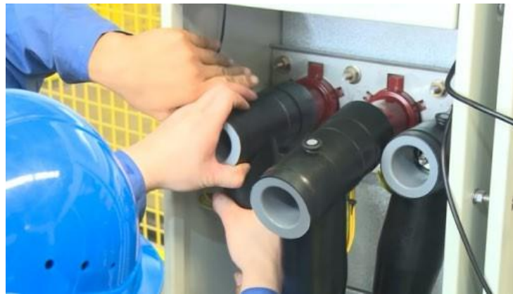
Figura 3-20 Empuje el cable en el conector en T
