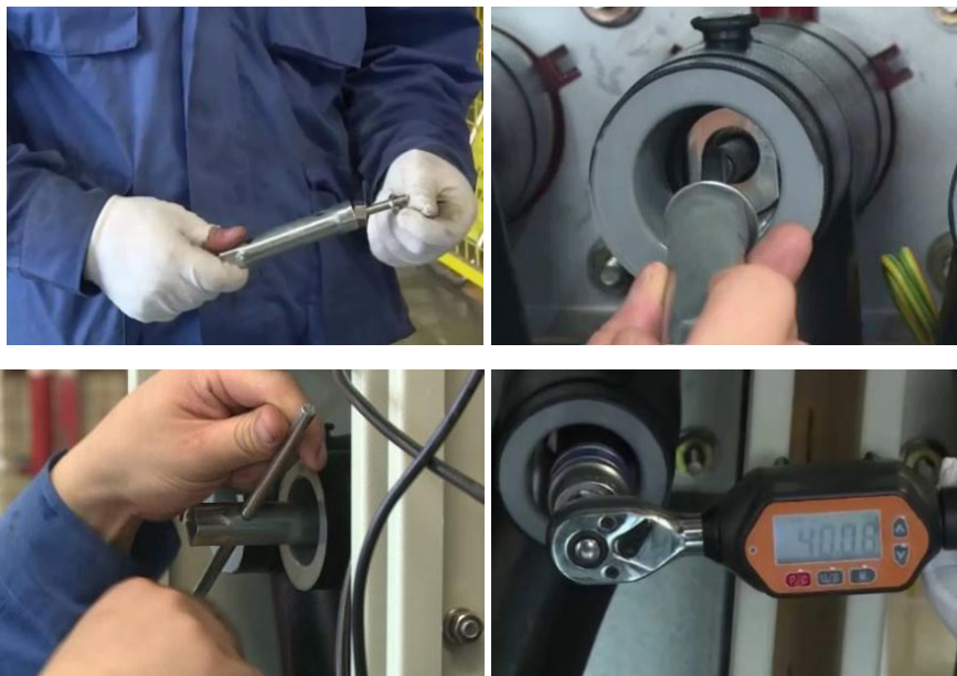
Figura 3-21 Empuje el conector en T y el adaptador de cable en el casquillo
