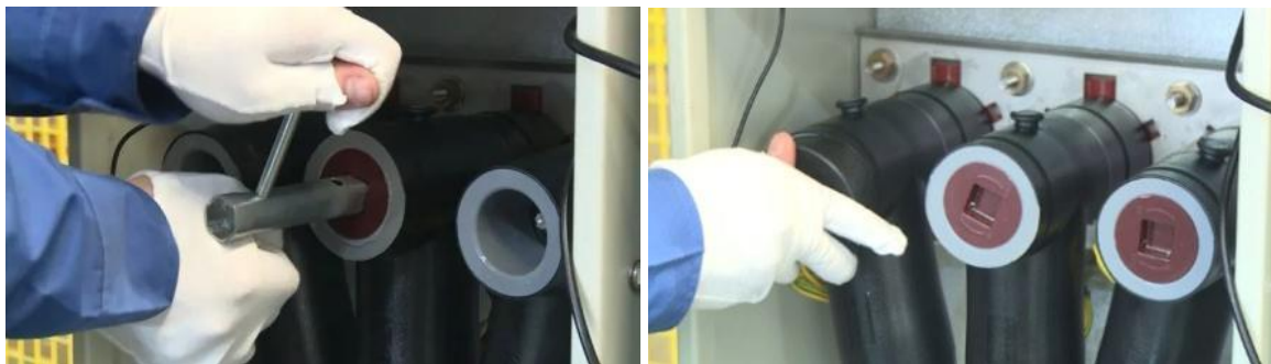
Figura 3-22 Instale a porca e a arruela
