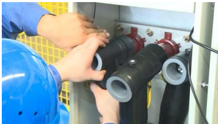
Figura 3-20 Empurre o cabo para dentro do conector em T
