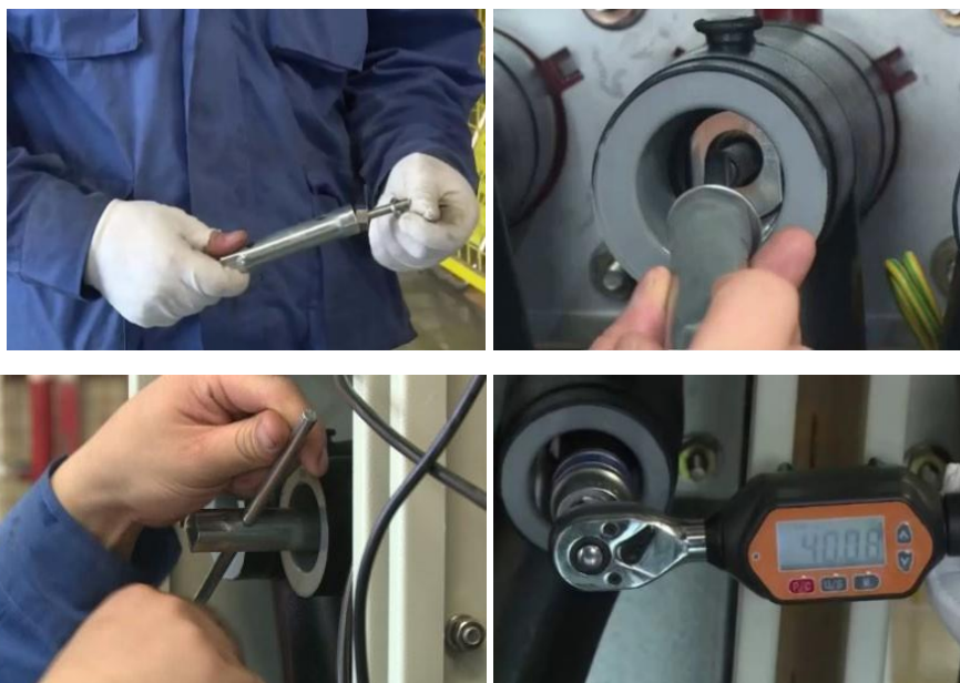
Figura 3-21 Empurre o conector em T e o adaptador de cabo para dentro da bucha
