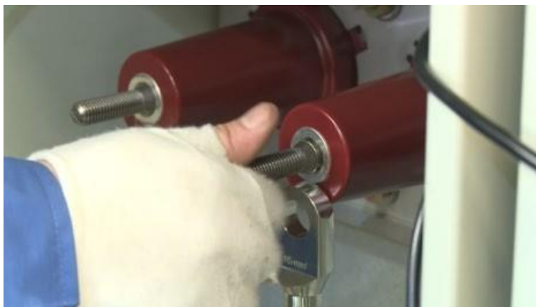
Figura 3-18 Insira os terminais em cada condutor de fase
